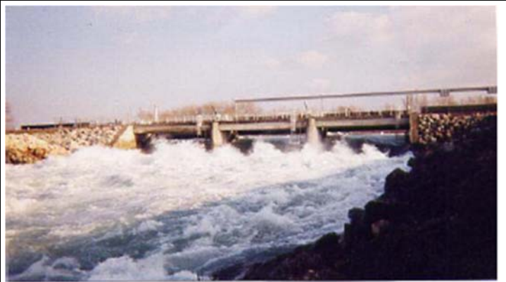
Le déversoir de Mallemort qui ouvre le canal EDF sur la Durance
